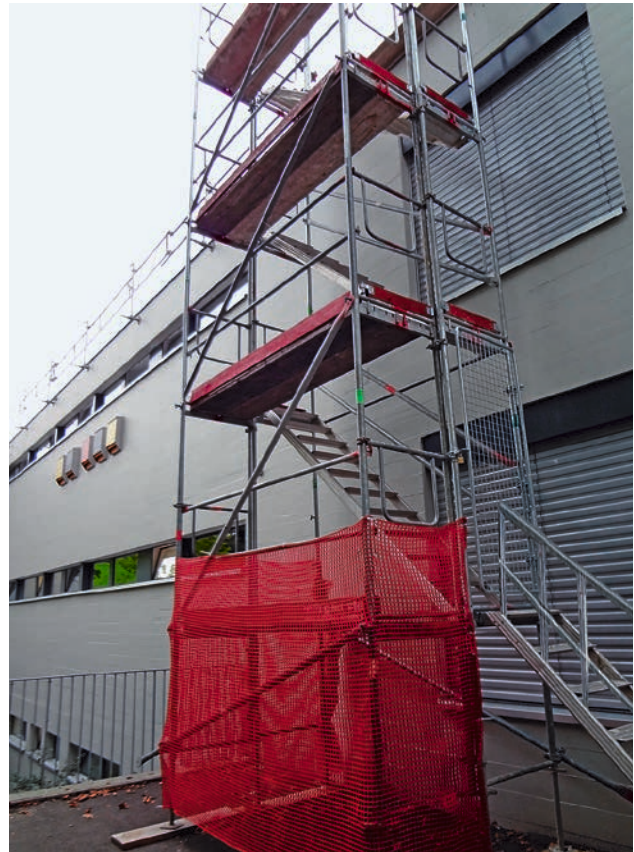
Bild 3 Sicherer Zugang über einen Treppenturm
