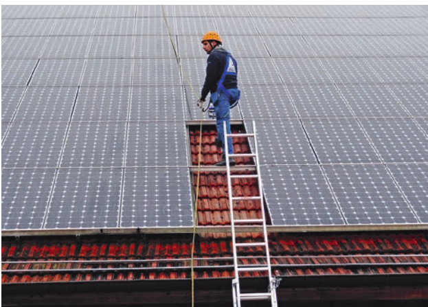
Bild 18 Überwurfseil, mit einem Mitläufer gesichert
