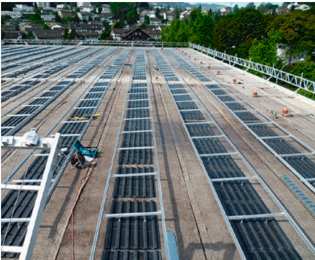
Bild 2 Montage einer Solaranlage mit umlaufendem temporärem Seitenschutz am Dachrand
