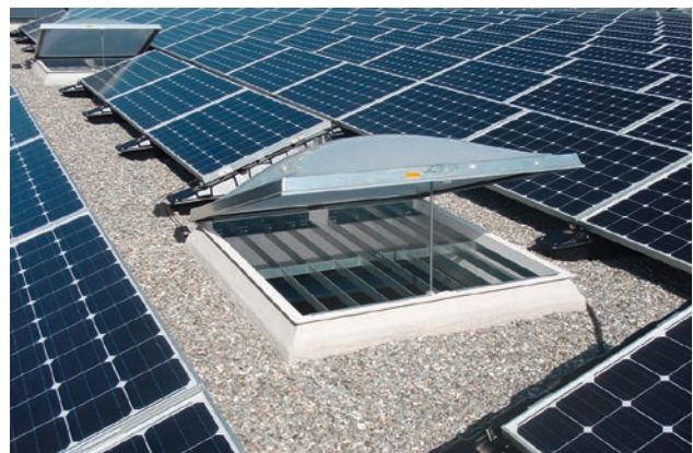
Bild 1 Oblicht, mit einem Gitter gegen Durchbruch gesichert
