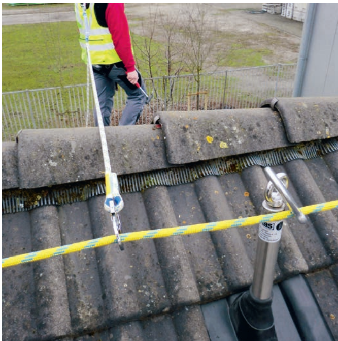
Abb. 9: Temporäres Seilsystem mit Kernmantelseil EN 1891
