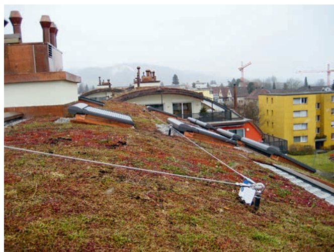
Abb. 6: Ausstattungsstufe 2; Seilsicherungssystem auf begrüntem Tonnendach
